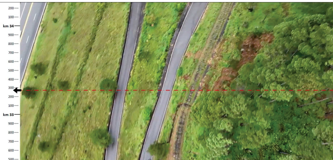
Figura 67 - Imagem aérea de drone - Erosão laminar em talude à montante
