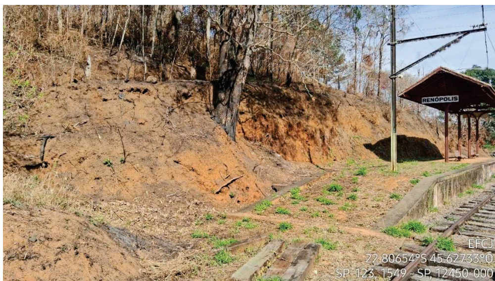
Figura 59 - Talude com processos erosivos intensos - Parada Renópolis
