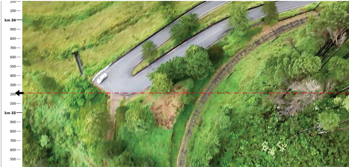
Figura 66 - Imagem aérea de drone - Erosão laminar em talude à jusante
