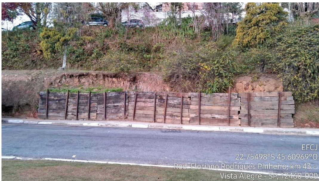
Figura 77 - Contenção improvisada com trilhos e dormentes
