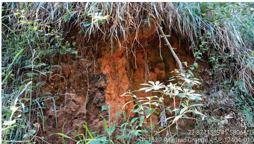
Figura 44 - Erosão laminar e rolamento de blocos em talude - Entrada do Parque Reino das Águas Claras
