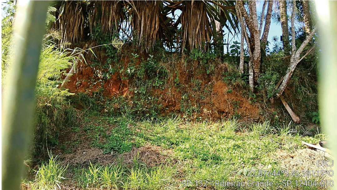
Figura 48 - Erosão laminar em talude - Entrada do Parque Reino das Águas Claras
