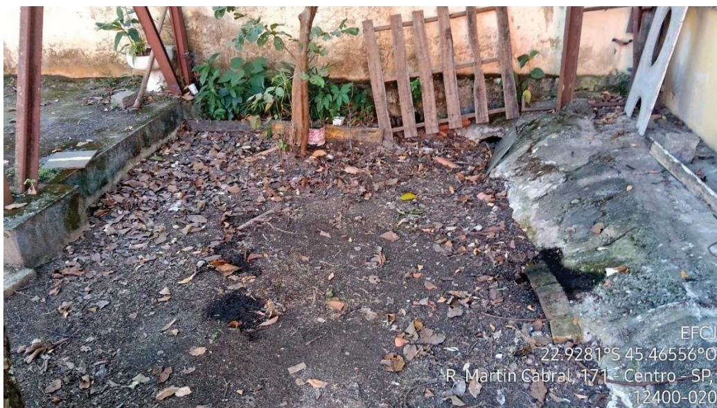
Figura 7 - Manchas de óleo em solo exposto - Pátio de Manutenção de Pindamonhangaba
