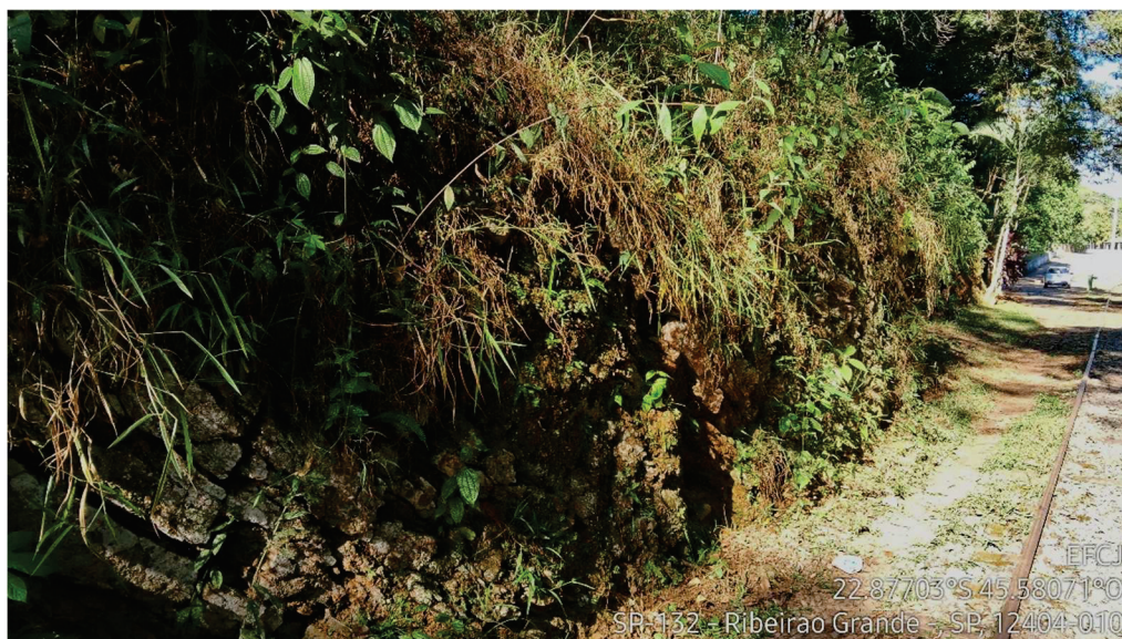
Figura 47 - Rochas fraturadas e rolamento de blocos em talude - Entrada do Parque Reino das Águas Claras
