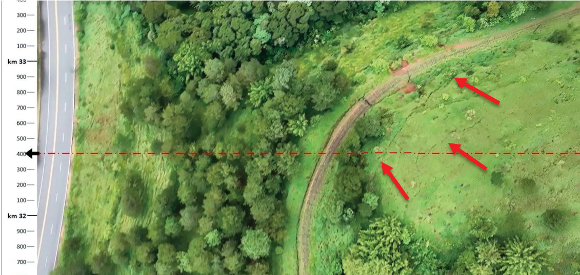
Figura 64 - Imagem aérea de drone - Processo erosivo de grande escala
