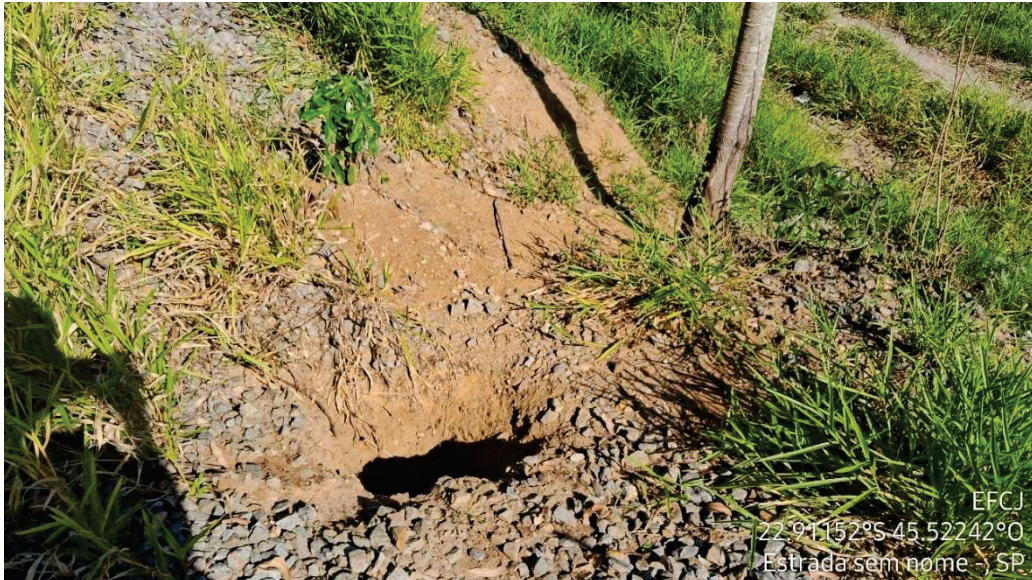
Figura 34 - Erosão laminar à jusante da via permanente
