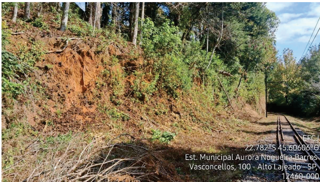
Figura 75 - Erosão laminar e árvores inclinadas e com raízes expostas - Lajeado
