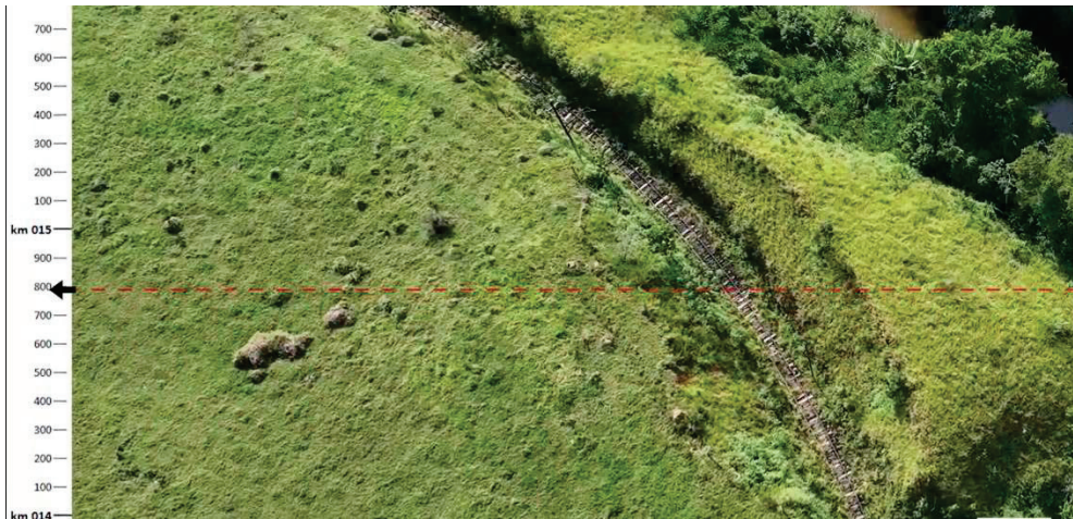
Figura 40 - Imagem aérea de drone - Talude com alta inclinação
