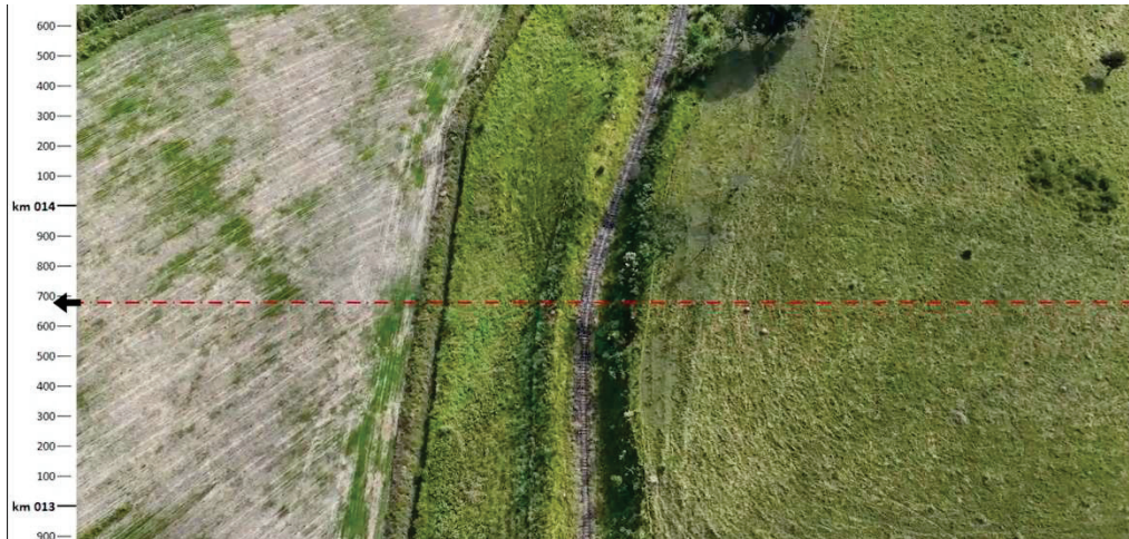
Figura 36 - Imagem aérea de drone - Talude com alto grau de inclinação e proximidade da via (2024)
