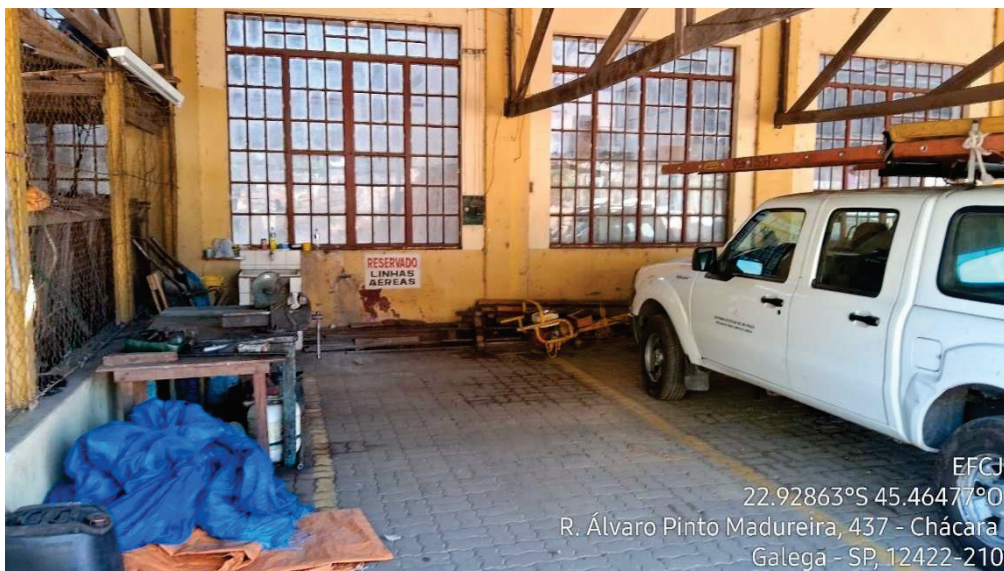
Figura 12 - Áreas de manutenção da oficina mecânica com manchas de óleo em piso de bloquetes - Pátio de Manutenção de Pindamonhangaba
