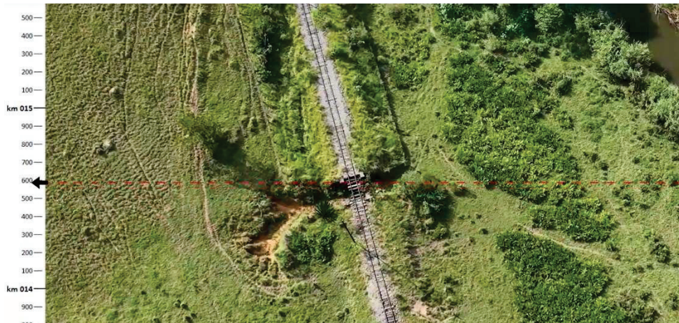
Figura 39 - Imagem aérea de drone - Erosão laminar em talude
