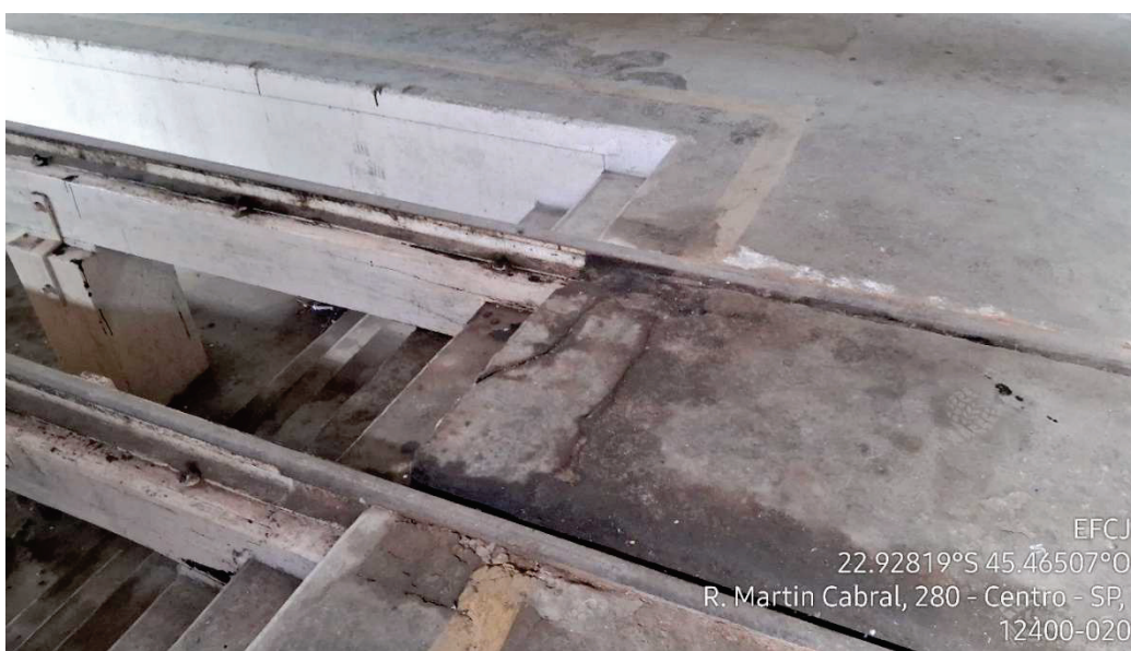
Figura 1 - Manchas de óleo em piso com fraturas - Pátio de Manutenção de Pindamonhangaba
