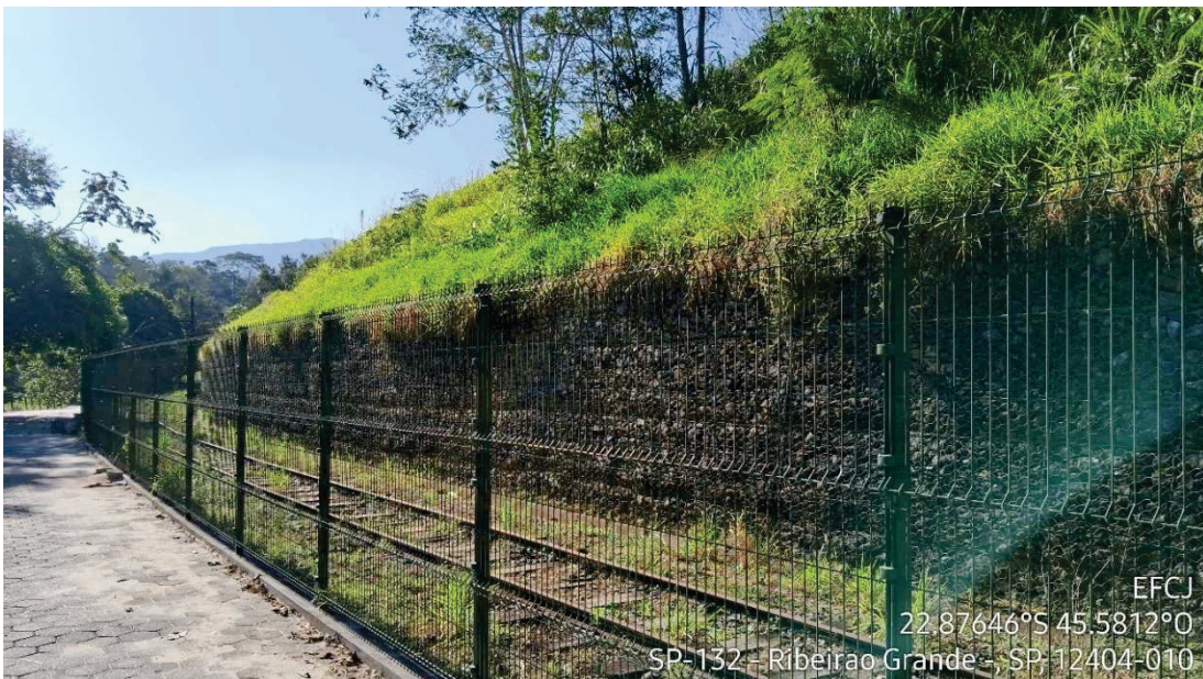
Figura 49 - Contenção de base de talude em gabião - Entrada do Parque Reino das Águas Claras
