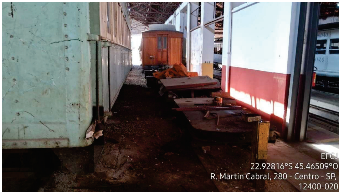
Figura 4 - Área de estacionamento de vagões e locomotivas com manchas de óleo em solo exposto - Pátio de Manutenção de Pindamonhangaba
