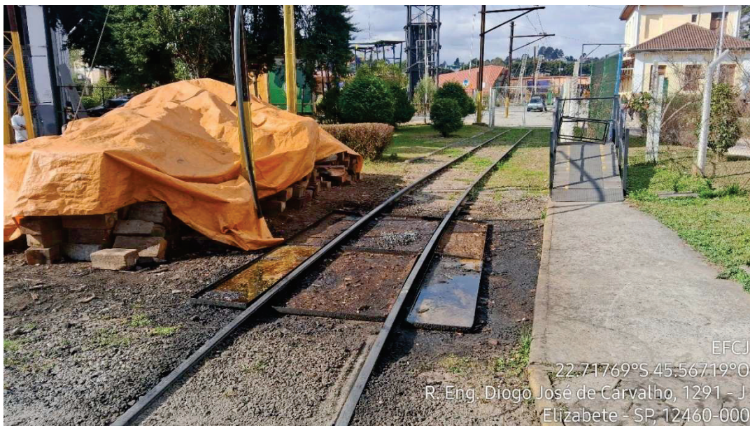
Figura 18 - Local de manobra da locomotiva turística, com bandeja de contenção para vazamentos de óleo. Manchas de óleo por sobre a brita e solo exposto - Pátio de Manutenção Capivari
