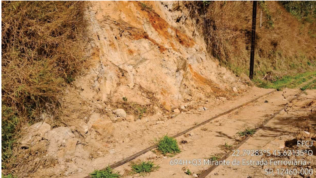
Figura 72 - Detalhe do processo erosivo
