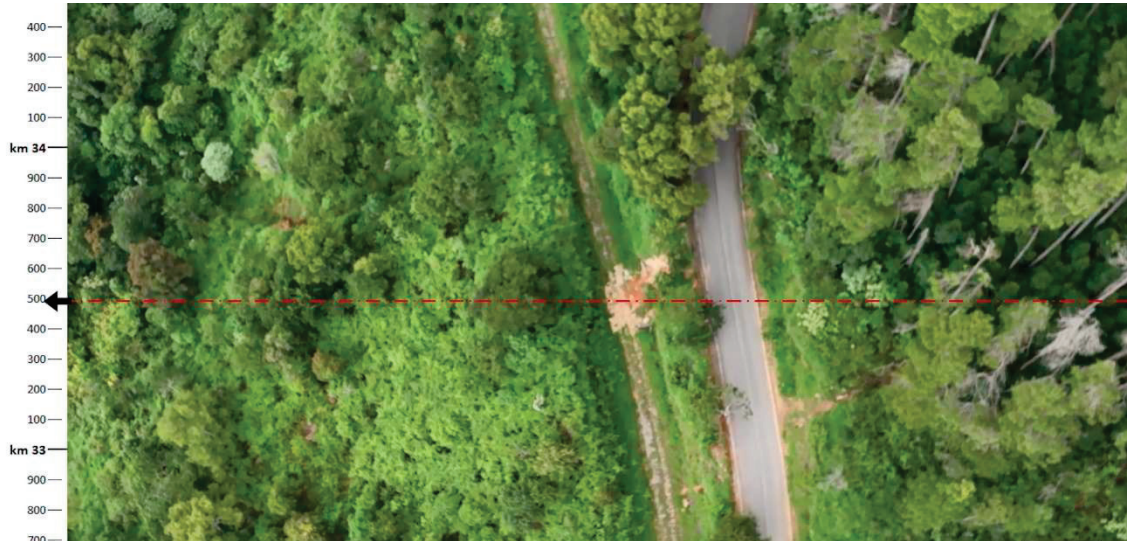
Figura 70 - Imagem aérea de drone - Erosão laminar e rolamento de blocos em talude à montante
