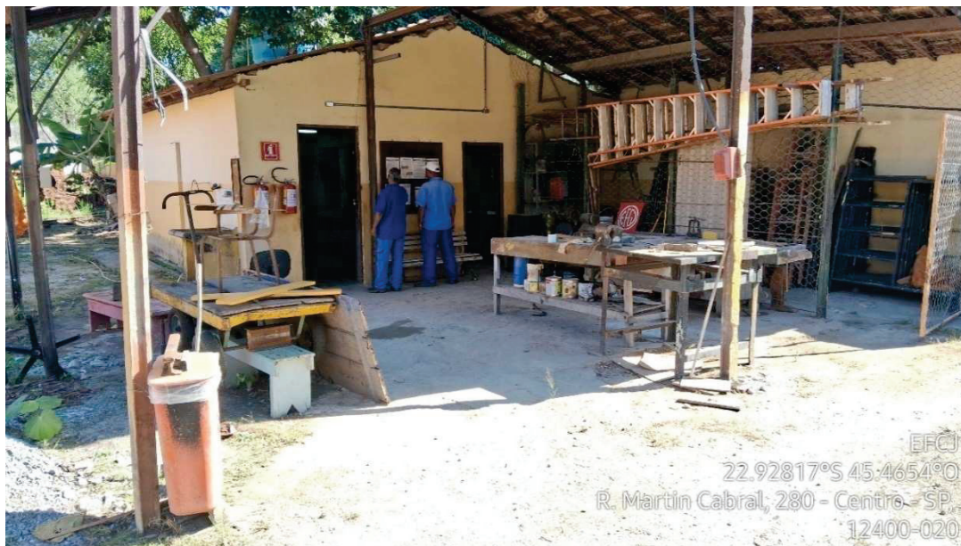
Figura 6 - Área de manutenção com manchas de óleo no piso e utilização de produtos com potencial de contaminação - Pátio de Manutenção de Pindamonhangaba
