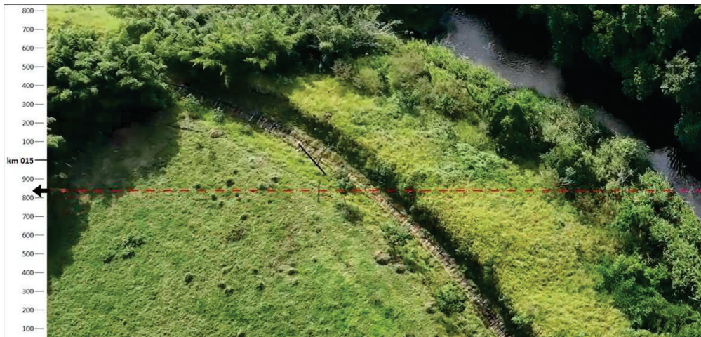
Figura 41 - Imagem aérea de drone - Talude com alta inclinação
