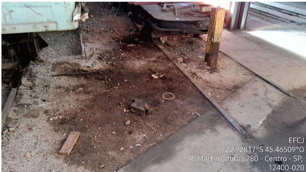
Figura 3 - Área de estacionamento de vagões e locomotivas com manchas de óleo em solo exposto - Pátio de Manutenção de Pindamonhangaba
