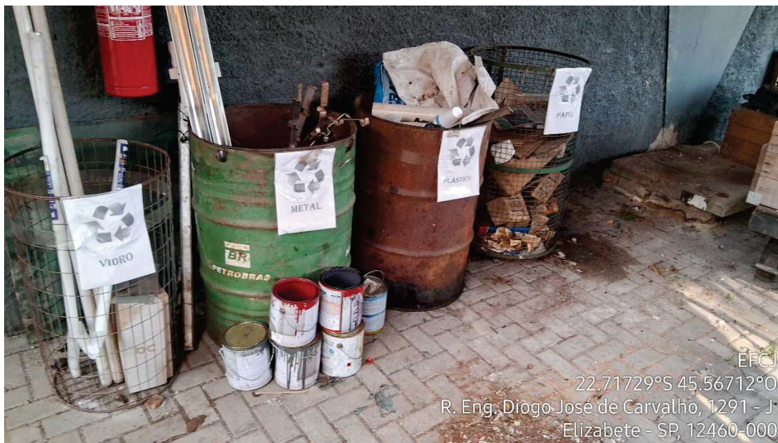
Figura 25 - Tambores para segregação de resíduos. Manchas de óleo e latas com resquícios de tinta por sobre piso de bloquetes
