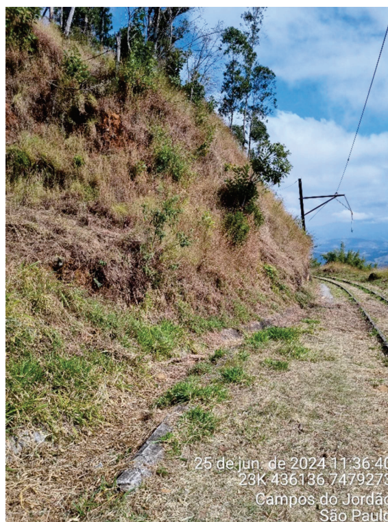
Figura 69 - Visão do geral do talude à montante
