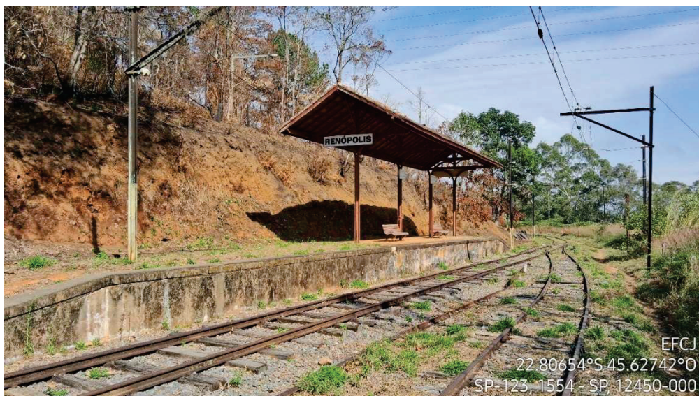
Figura 60 - Talude com processos erosivos intensos - Parada Renópolis
