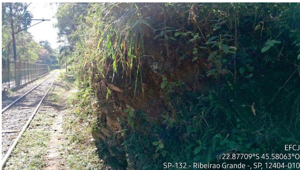
Figura 46 - Rochas fraturadas e rolamento de blocos em talude - Entrada do Parque Reino das Águas Claras
