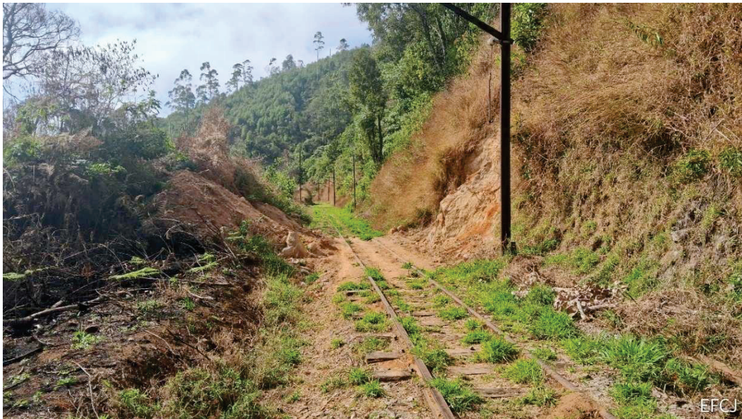
Figura 71 - Erosão laminar e rolamento de blocos em talude à montante
