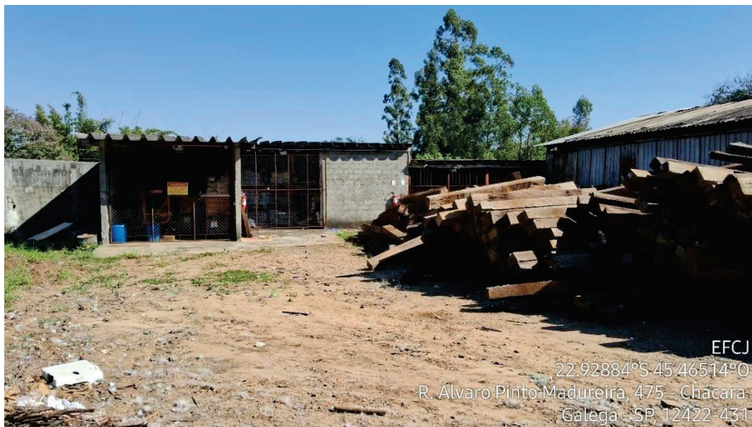
Figura 10 - Área de disposição de dormentes e galpões de armazenamento de combustíveis e produtos perigosos - Pátio de Manutenção de Pindamonhangaba
