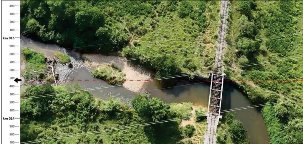
Figura 38 - Imagem aérea de drone - Ponte sobre rio Piracuama
