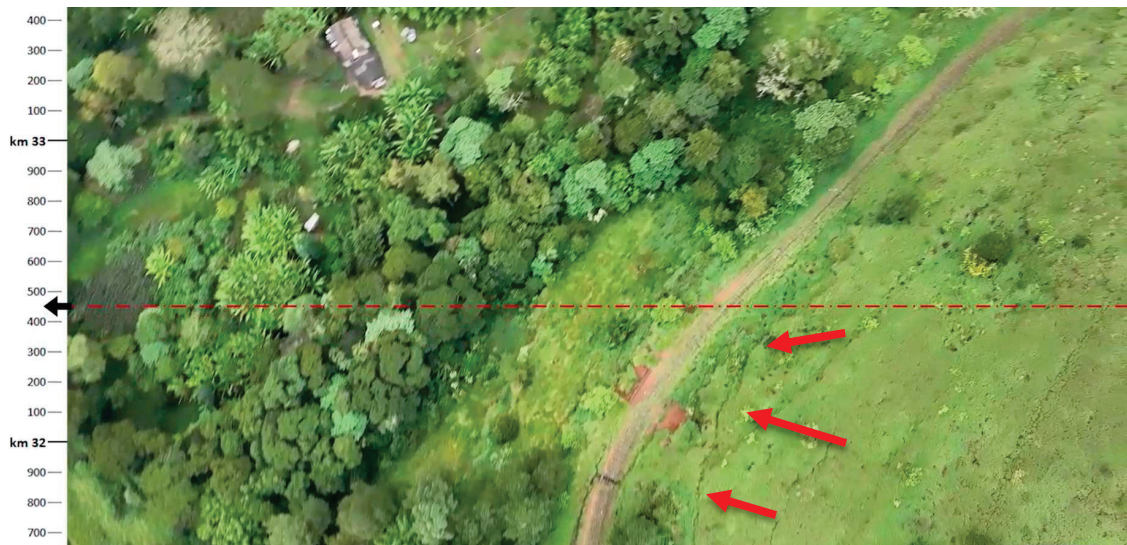
Figura 65 - Imagem aérea de drone - Processo erosivo em grande escala
