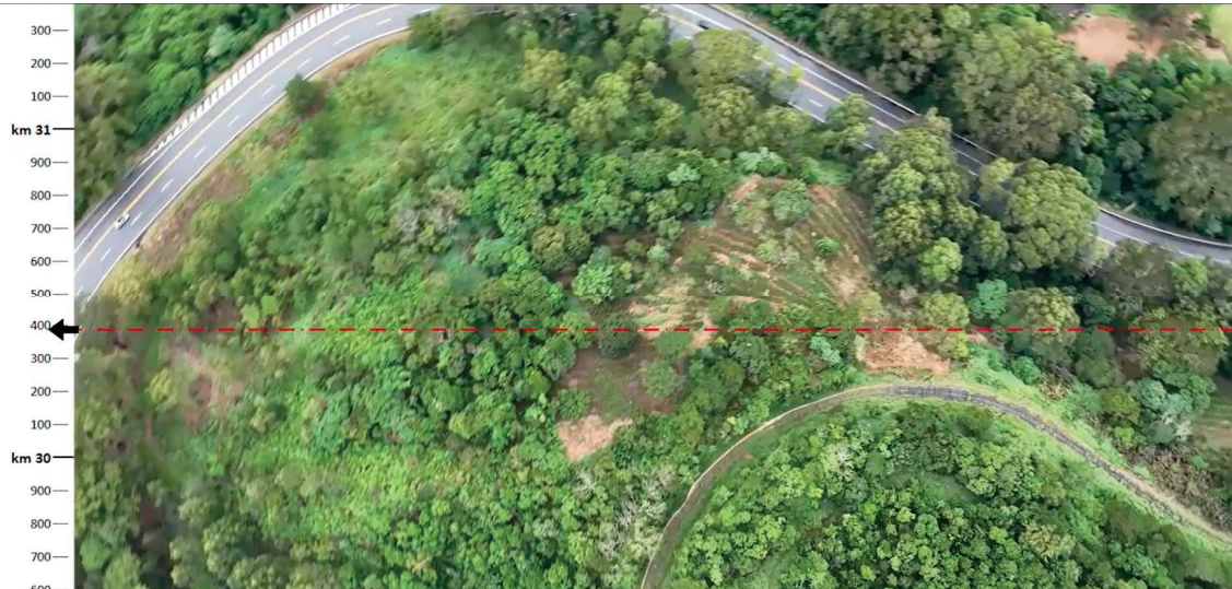
Figura 62 - Imagem aérea de drone - Erosão laminar em talude à jusante da via
