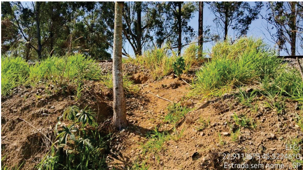
Figura 35 - Erosão laminar à jusante da via permanente
