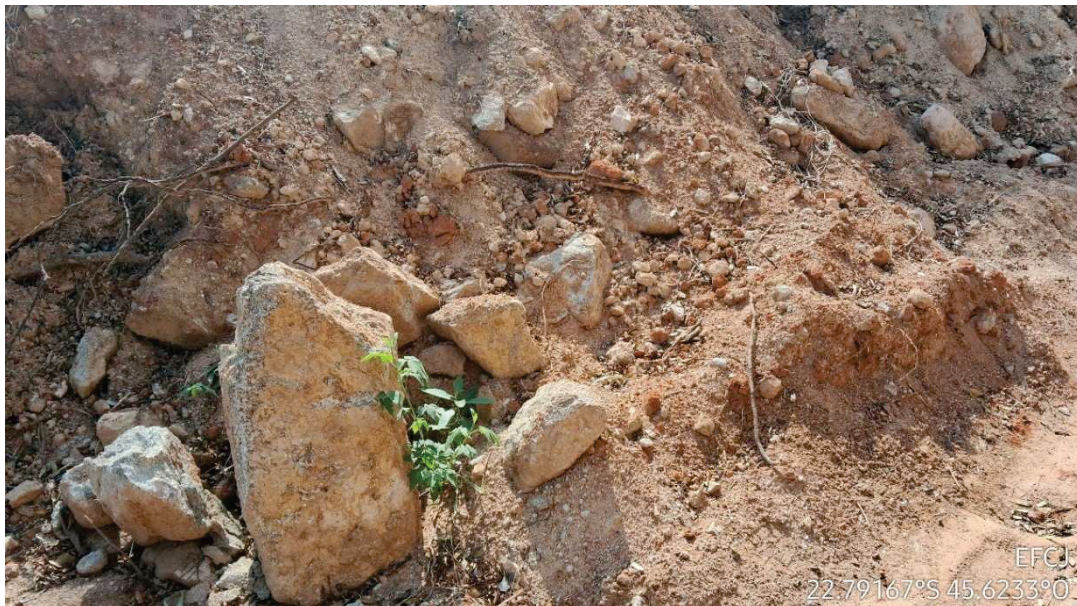
Figura 73 - Detalhe dos blocos de rocha de alteração desprendidos
