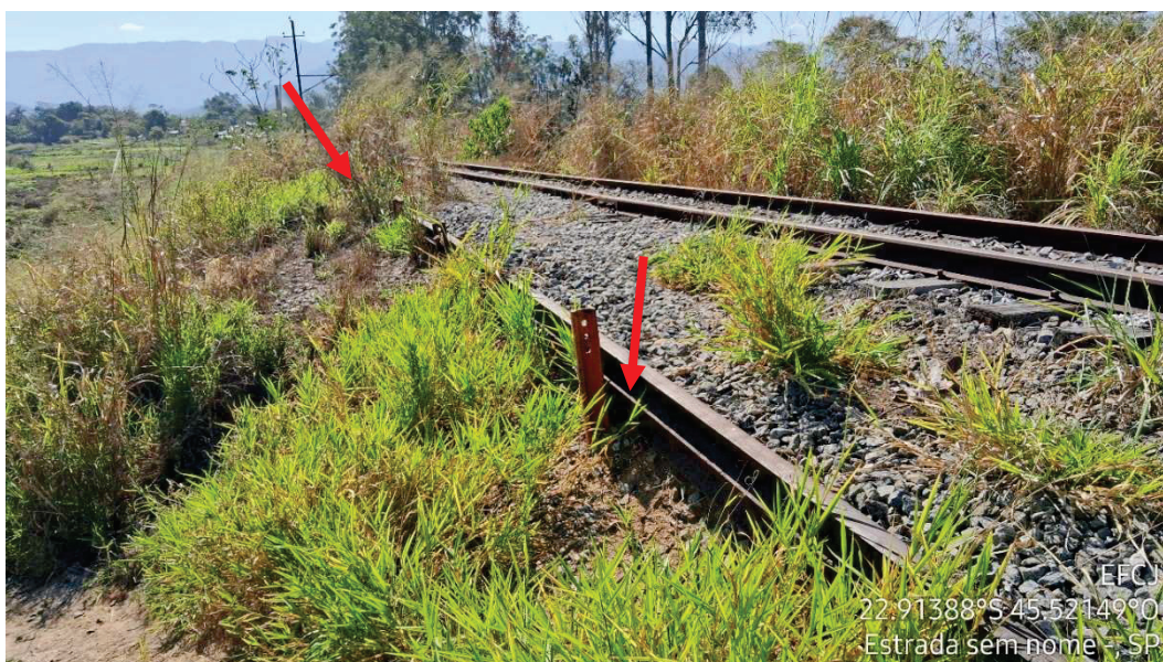
Figura 32 - Contenção de leito da ferrovia com a utilização de trilhos (2024)
