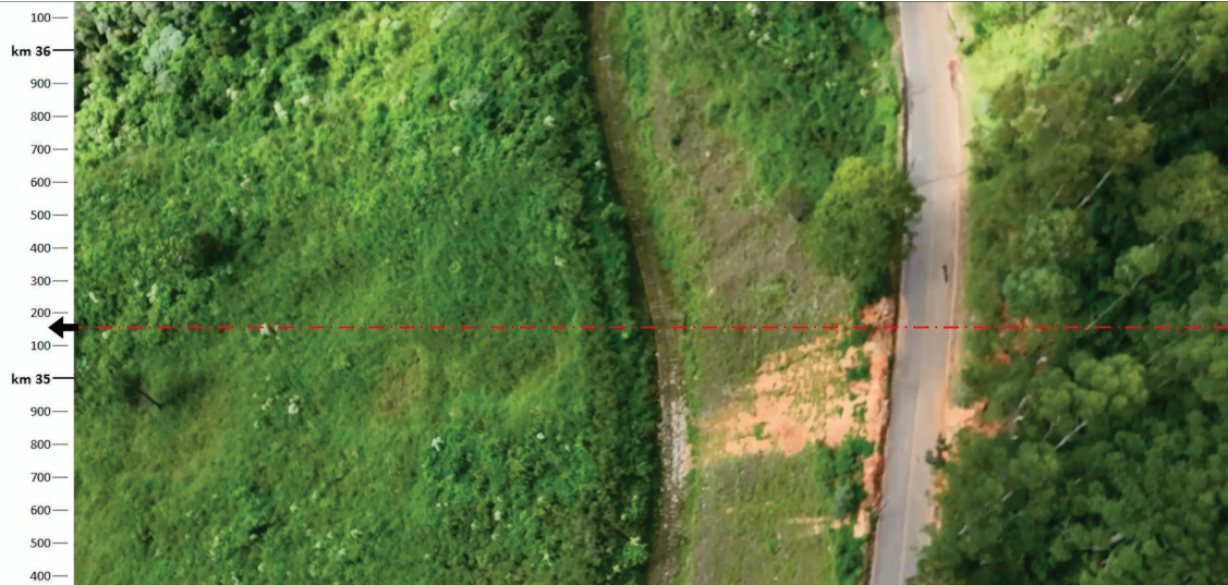
Figura 74 - Imagem aérea de drone - Processo erosivo em lindeiro
