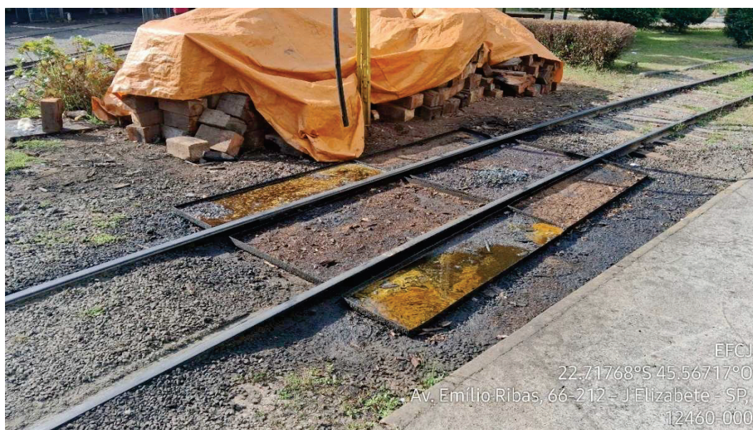
Figura 17 - Local de manobra da locomotiva turística, com bandeja de contenção para vazamentos de óleo. Manchas de óleo por sobre a brita e solo exposto - Pátio de Manutenção Capivari
