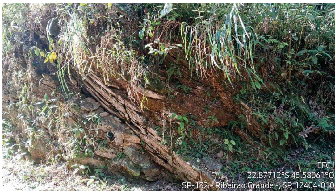
Figura 45 - Rochas fraturadas e rolamento de blocos em talude - Entrada do Parque Reino das Águas Claras
