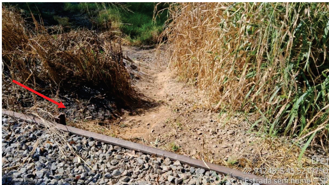
Figura 33 - Contenção de leito da ferrovia com a utilização de trilhos
