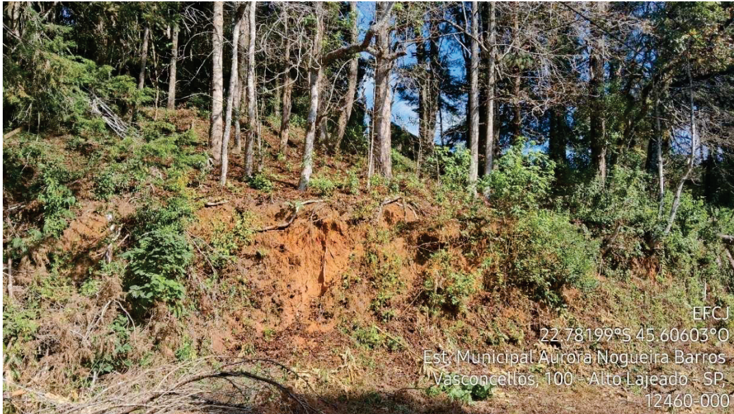
Figura 76 - Detalhe do processo erosivo - Lajeado
